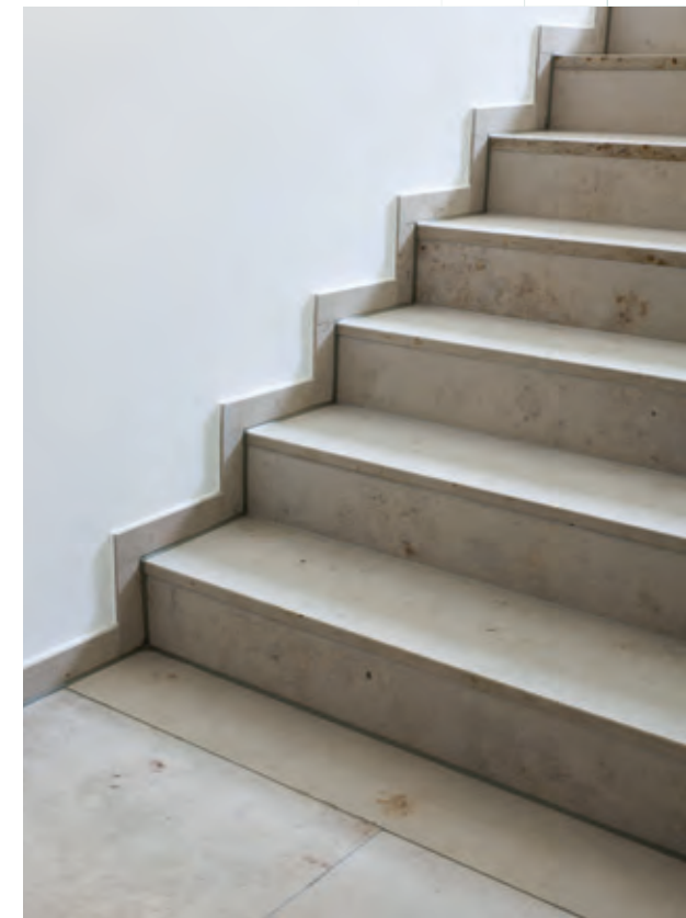
Naturstein-Boden in den Treppenhäusern aus Kalkstein
